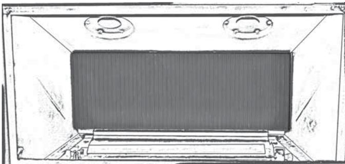
3. Pivotez le support d'ancrage du panneau vers l'arrière et glissez le panneau gauche contre la paroi de la boîte de foyer. **Le panneau devrait être parallèle au bord de la plaque du brûleur.** Pivotez le support d'ancrage vers le bas pour retenir le panneau.
