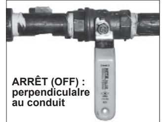
ARRÊT (OFF) : perpendiculaire au conduit
