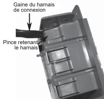
6. Fixez la boîte de raccordement en position finale en utilisant les vis appropriées (non-incluses).
