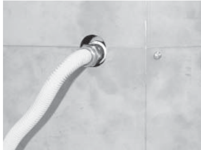
Raccord souple redirigé à l'aide d'un coude
